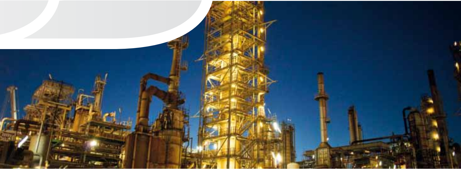
SARAS - Impianto di raffinaria, Sarroch, Cagliari
