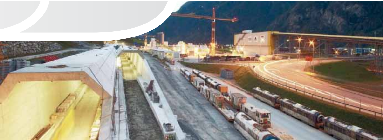
STRABAG - Cantiere del tunnel di base del San Gottardo, Erstfeld, Svizzera
