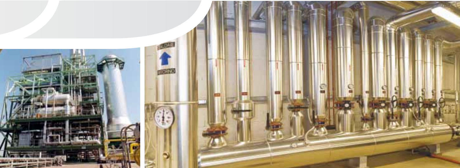
ACEA - Impianto di trigenerazione di Tor di Valle, Roma
